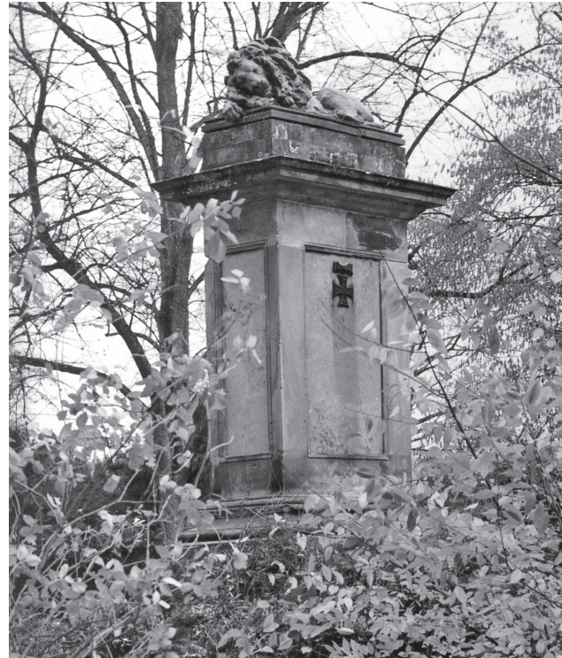
Bild 8: Das Ehrenmal für die gefallenen Artilleristen im Krieg 1870–1871 ist nach der Restauration bis heute in einem guten Zustand.
